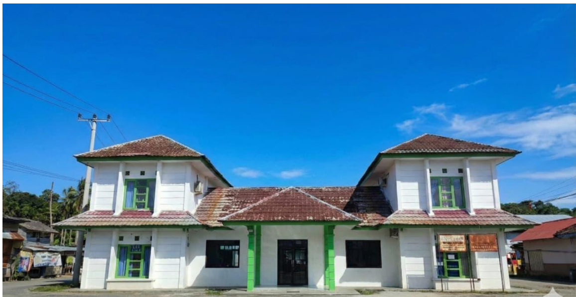
Gambar 2. 1 Kantor Dinas Perhubungan Kabupaten Pesisir Barat
