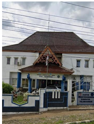
Gambar 1. Kantor Dinas Perhubungan Kabupaten Tulang Bawang
